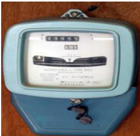
Dans ce cas, il s'agit d'un compteur **électromécanique**:
